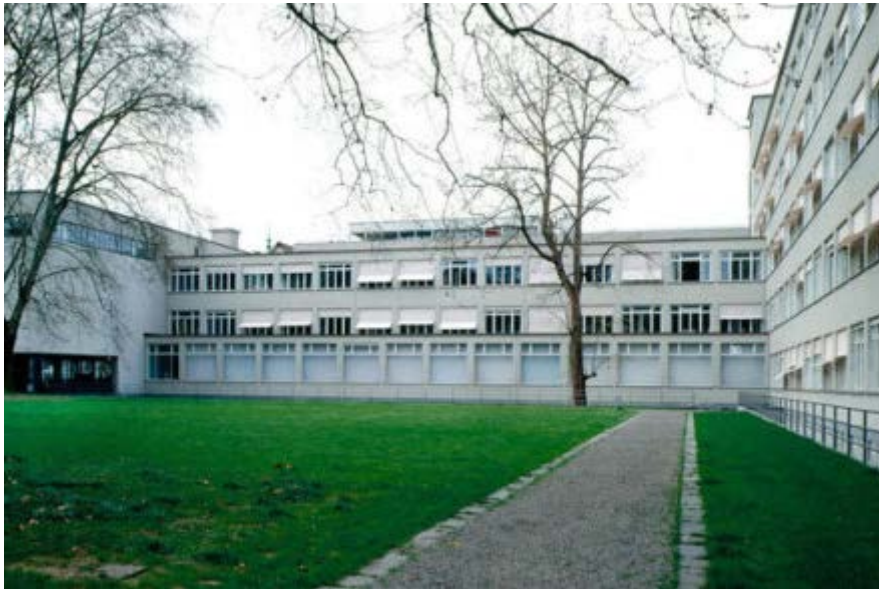
Sanierung Schultrakt Sihlquai 87
